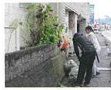
▲衛生部の作業風景
