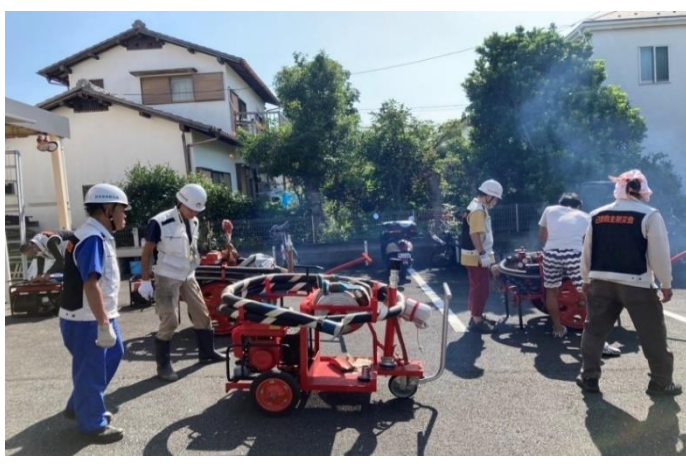
消防ポンプの点検の様子
