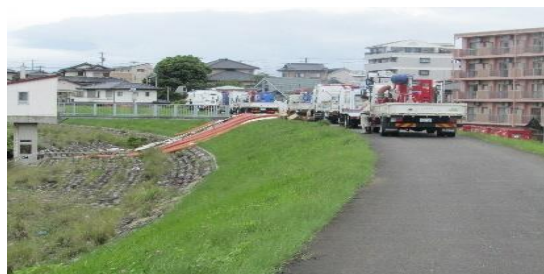
木瀬川第一樋管
