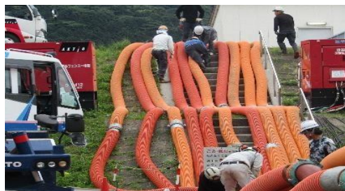
狩野川土手・配管
